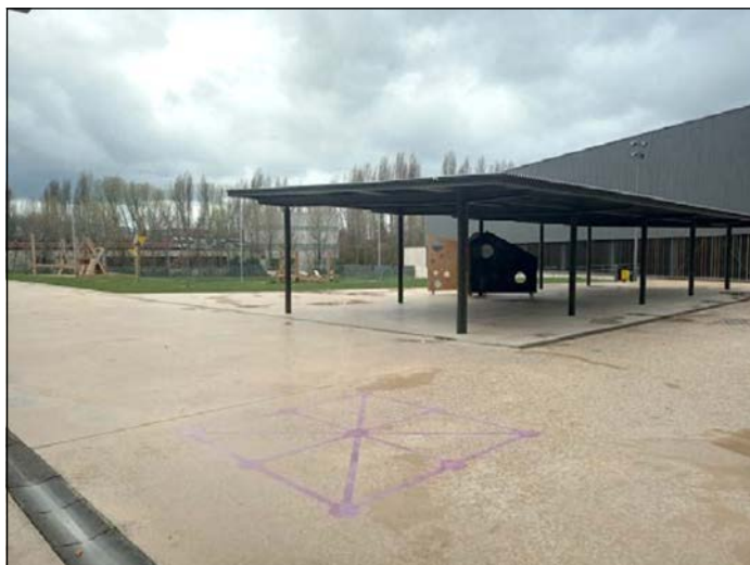
Figura 5. Vista de la zona 4, paredes interactivas
